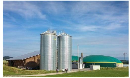
Das Biogas wird dann verbrannt und die entstandene Hitze wird verwendet, um Wasserdampf zu erzeugen. Der Dampf treibt dann eine Dampfturbine an und erzeugt Strom. Mit der überschüssigen Wärme können nahegelegene Häuser geheizt werden.
