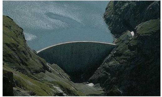
Speicherwasserkraftwerke speichern in grossen Seen Schmelzwasser aus den Bergen, sowie Quell-, Fluss- oder Regenwasser. Wasser, das in einen tieferliegenden, zweiten See oder Fluss geleitet wird, treibt eine Turbine (ein Wasserrad) an, welche Strom erzeugt. Einfache Stauseen erzeugen auf
