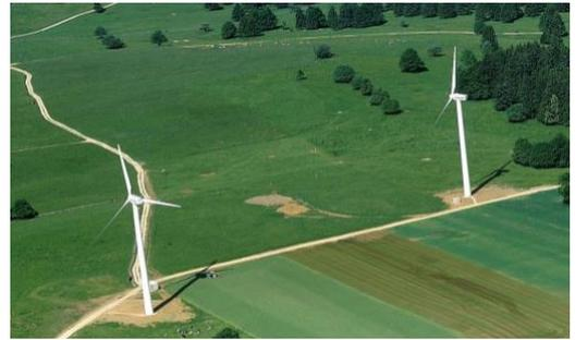
Anlage antreiben und somit Strom produzieren. Der Rotor passt sich an die Windrichtung und –geschwindigkeit an, um möglichst viel Strom zu erzeugen. Bei einem Sturm stoppt die Anlage automatisch und die Blätter wenden sich ab. Es gibt einzelne Windkraftwerke oder ganze Parks.
